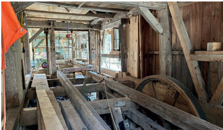
Blick in die ehemalige Säge, die wieder funktionsfähig werden soll. Bild: HSF
