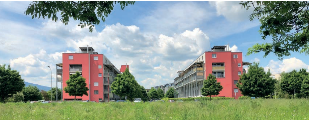
Bild 17: Mehrfamilienhäuser Bostudenstrasse 8 und 10, 2025 (Bild: Autor)
