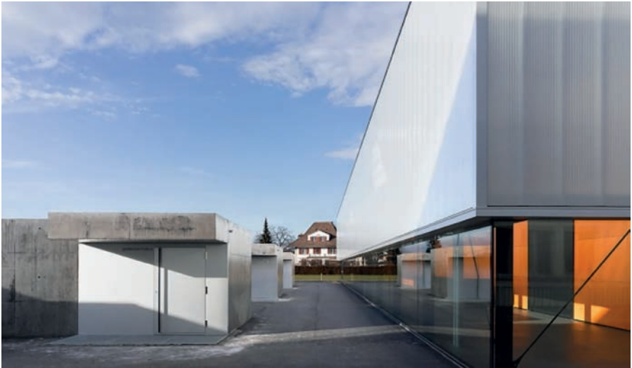
Bild 21: Rechts die Sporthalle, links die Abgänge zu den Garderoben, ganz im Hintergrund das Pfarrhaus bei der Markuskirche (Bild: Alexander Henz, www.mv.architekten.ch )
