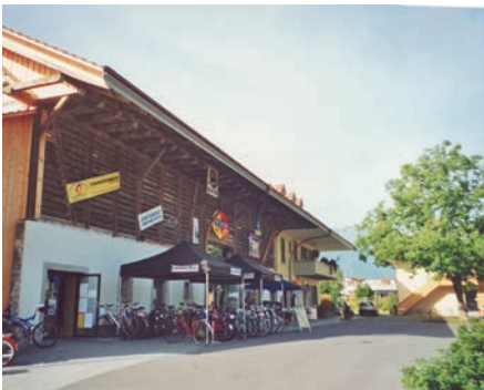
Bild 29: Talackerstrasse 47 kurz nach der Renovation, im Hintergrund das Stöckli (Bild: thunenis).
